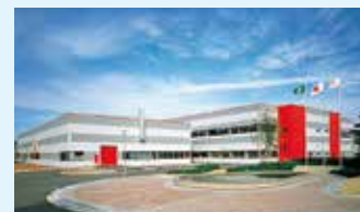
●新潟にある本社工場
