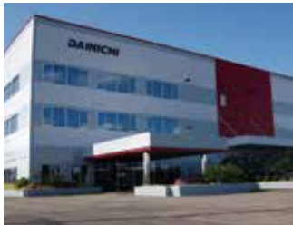
<中之口工場外観>
